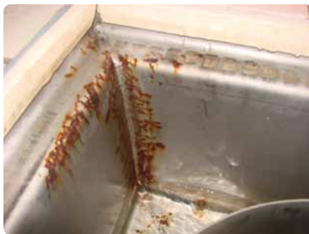
Korrosion i skvulperende
