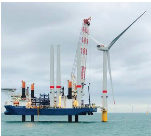
Foto: MHI Vestas Offshore Wind
