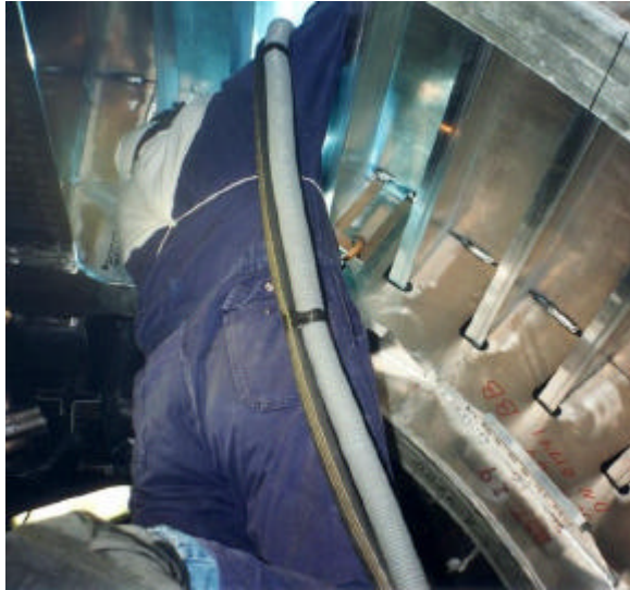
Figur 3.185 Vanskelige adkomstforhold kan betyde, at man bør overveje specifikke tillægsprøver, som afspejler den aktuelle arbejdssituation, (Bilcon A/S).
