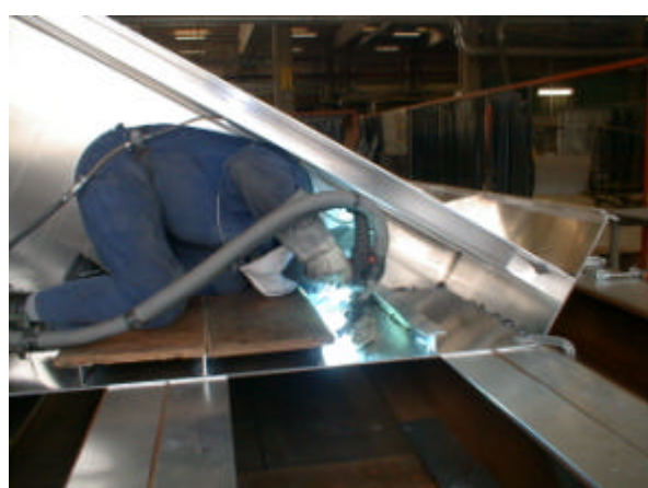
Figur 2.156 Dårlig adkomst i spidsen i en 30^{\circ} vinkel, svejsning af den anden inderste longitudinal.
