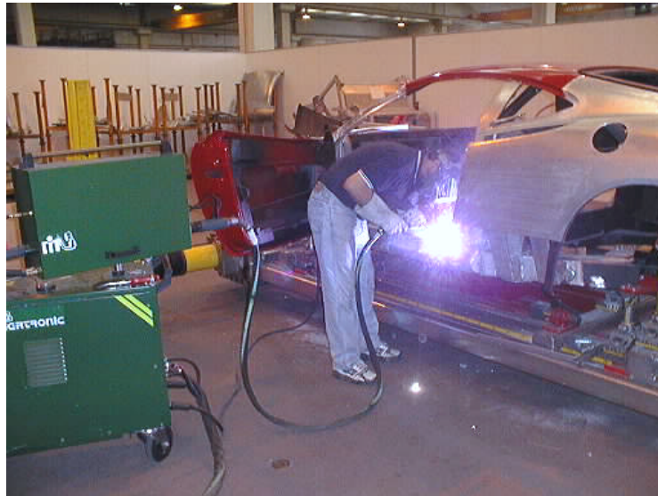
Figur 3.130 Ved reparationer i mindre godstykkelser kan det være fordelagtigt at anvende MIG-svejsning med en AISi-12 tråd. (Svejsereparation på Ferrari sportsvogn).
