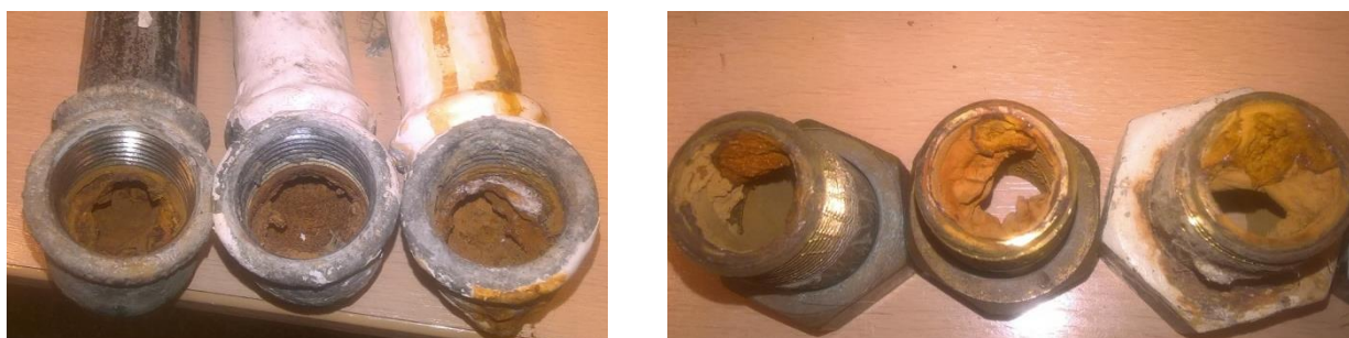
Figur 38 Kik ind i rør udtaget fra faktiske installationer.
