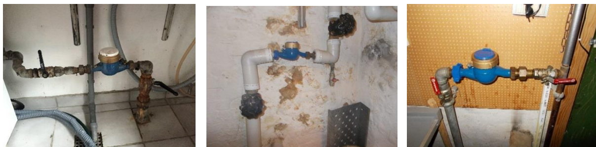
Figur 11 Installationseksempler af typen "vinkel-ventil-ret rør"
