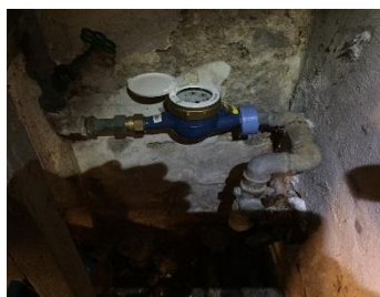
Figur 13 Installationseksempler af typen "vinkel-vinkel-..."
