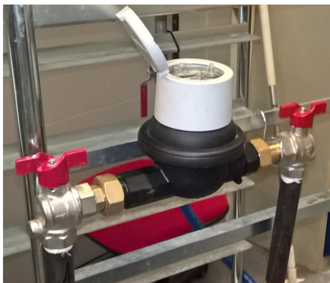
Figur 39 Øverst til venstre lige rør m/u rustangreb. Nederst venstre side: brøndfitting med vinkelventiler (ny), Højre øverst rør og vinkel med rustangreb. Højre nederst viser indløbet.
