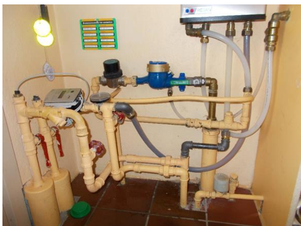
Figur 12 Installationseksempler af typen "ventil-vinkel-ret rør"
