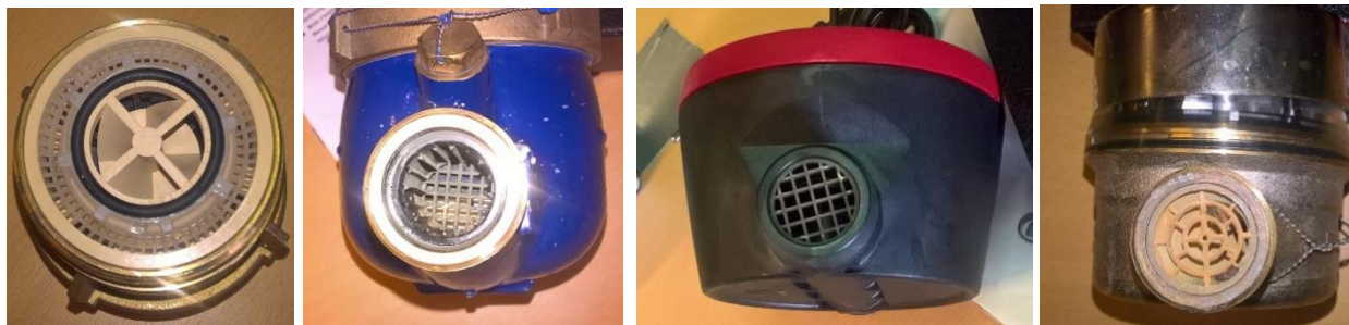
Figur 22 Forskellige typer af sier. Til højre en si, hvor der er indfanget partikler (rustflager).
