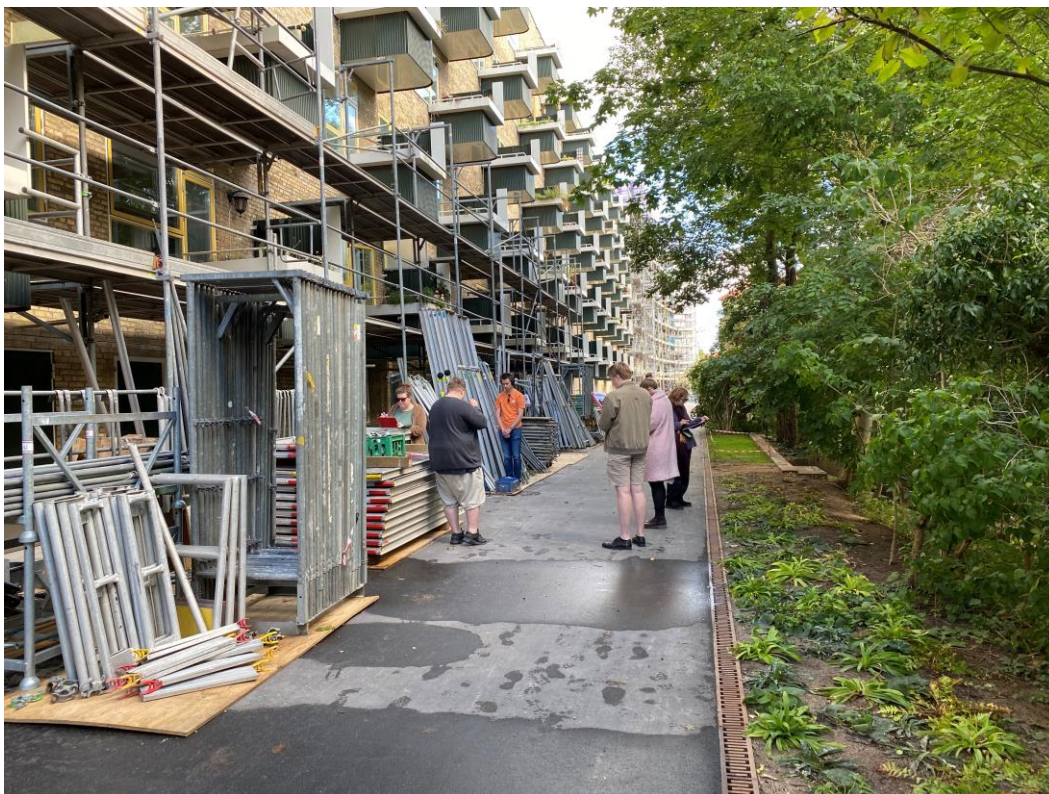
Figur 5 Position 3. Passagen langs bygningen. Øverst før og nederst efter anlæggelsen af gårdhaven, men med stilladser fra reovering af bygningen.
