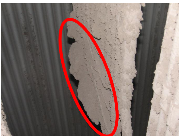
Figur 11 Billede af askeopbygning på SH3-rørene set ovenfra, der viser store klumper af askeaflejring på forsiden af rørene, der vender mod strømmingen.
